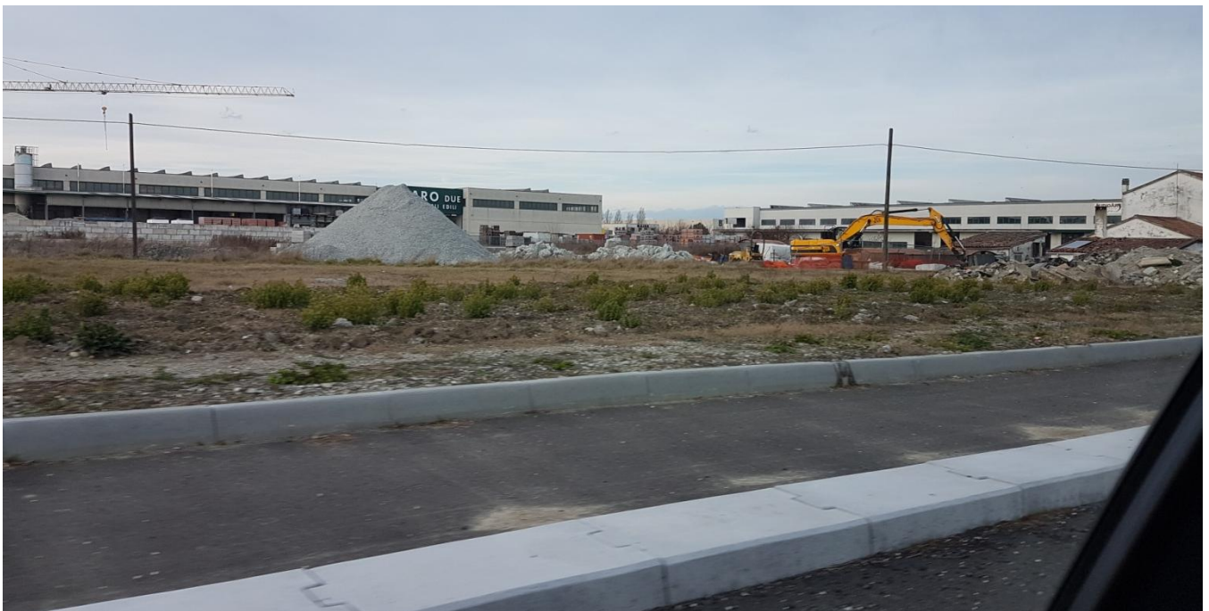
Foto 4: vista dalla SS 71 bis (sud)
