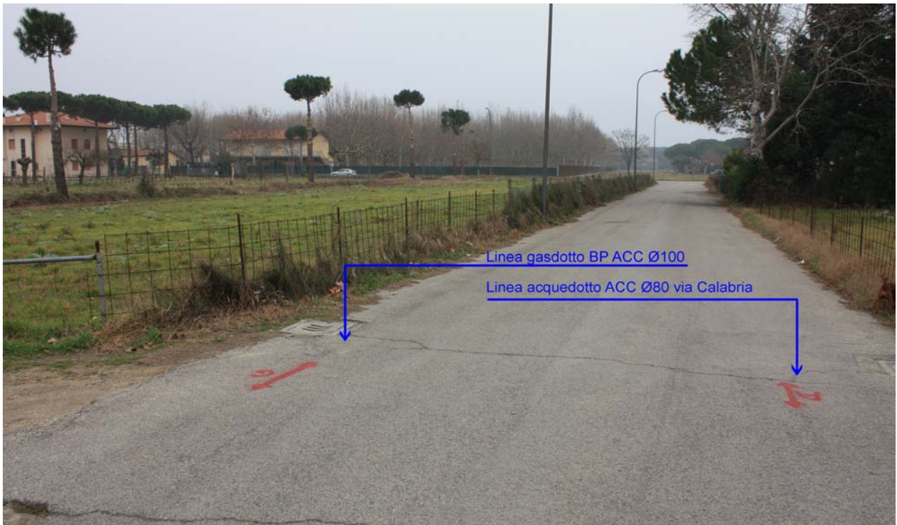
Rilievo condotte HERA sotto via Calabria
