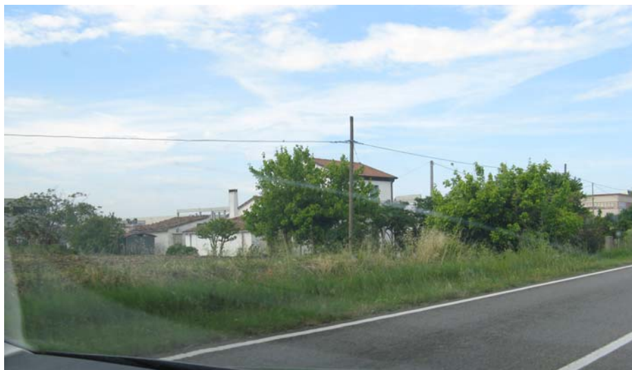
Foto 3 vista dalla SS 71 bis: edificio esistente
